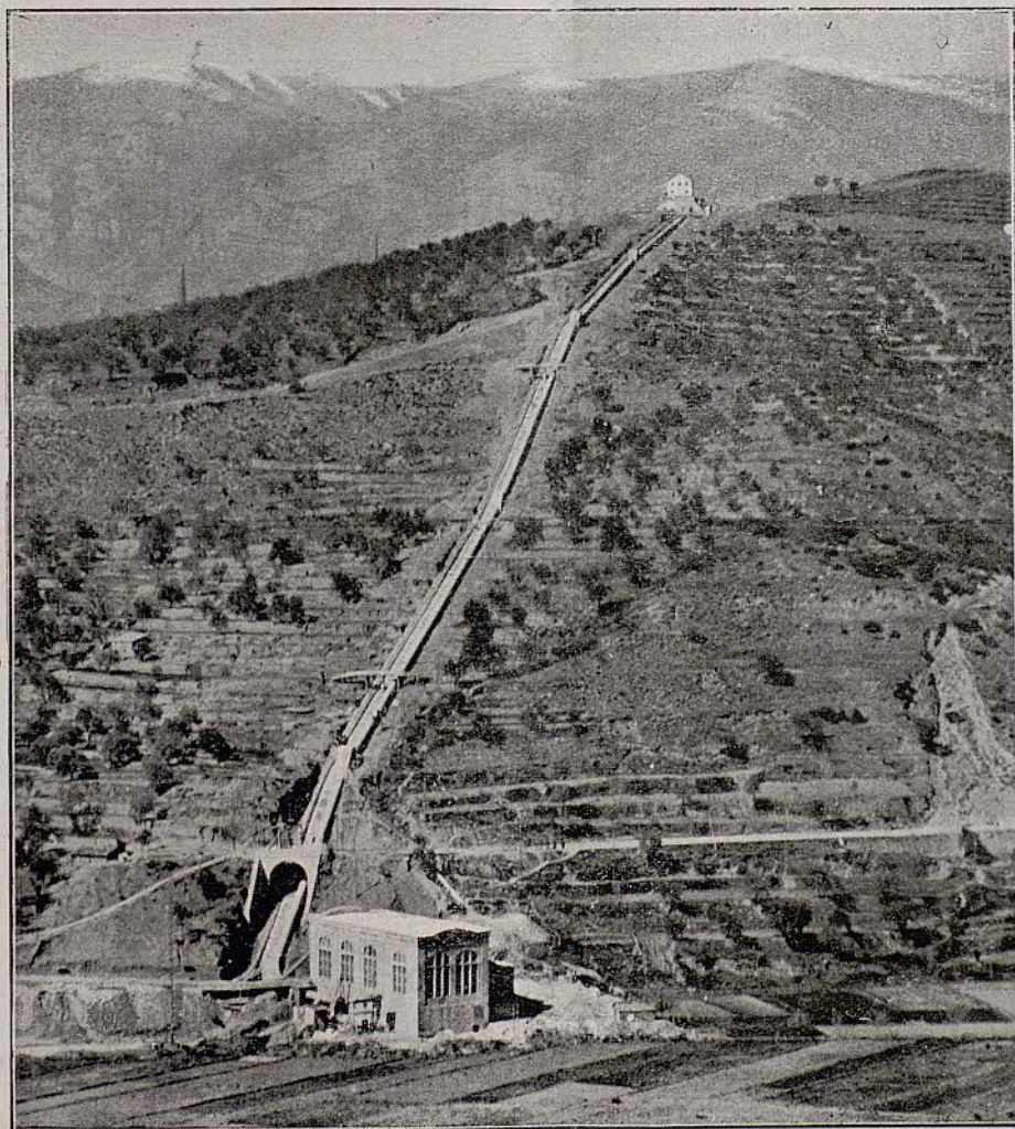
Vista general de la tubería ya instalada.
