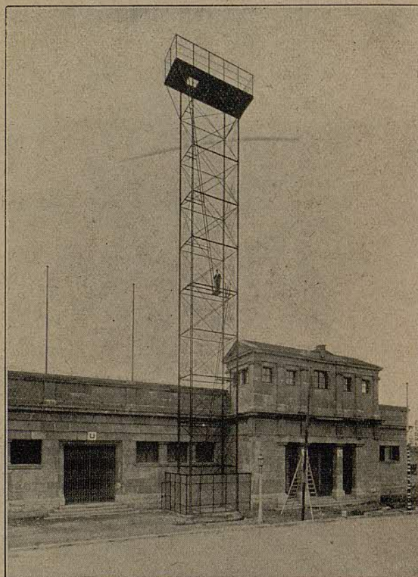
Fig. 12. Detalle de una torre para 20 proyectores
