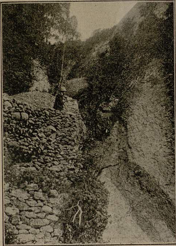
Una parte de la trinchera donde se ven los depósitos formados con las piedras arrancadas. — 17 de octubre de 1917.
