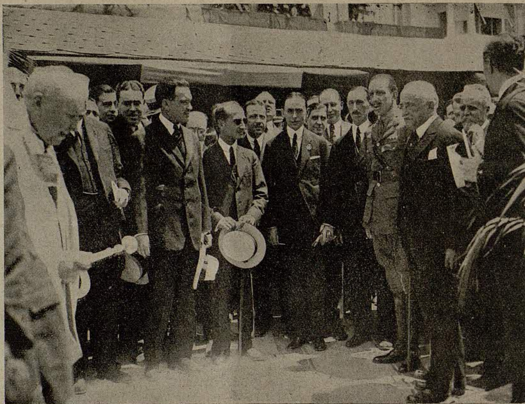
Acto de la bendición de las obras.
