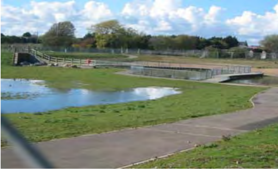
Fig. 1.70 Ejemplo de depósitos o cuencas de infiltración
