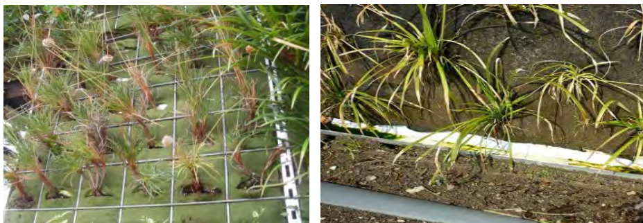
Figs. 2.15-2.16 Detalles de la fachada
