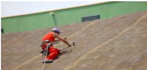
Fig. 2.66-2.67-2.68 Colocación de la manta orgánica
