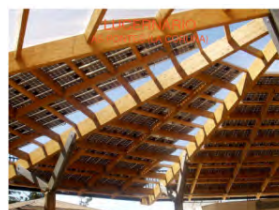
Fig. 4.18 Parque Tecnológico de Andalucía (Málaga)
