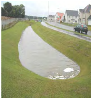
Figs. 1.75 y 1.76 Ejemplo y esquema de detalle de cuneta verde
