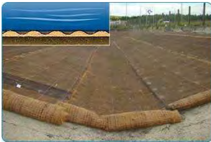
Fig. 1.80 Cuneta verde. Sistema constructivo. Fuente: Aquanea
