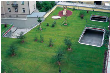
Figs. 2.38-2.39- 2.40 Ejemplos de cubierta intensiva. Fuente: ZinCo
