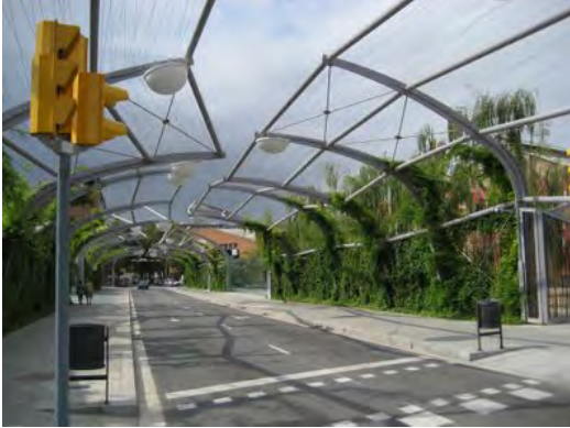
Fig. 2.25 Derecha: Pérgola de estructura metálica con recubrimiento vegetal
