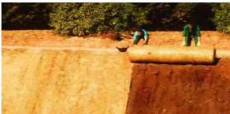
Fig. 2.64 Colocación de la manta orgánica
