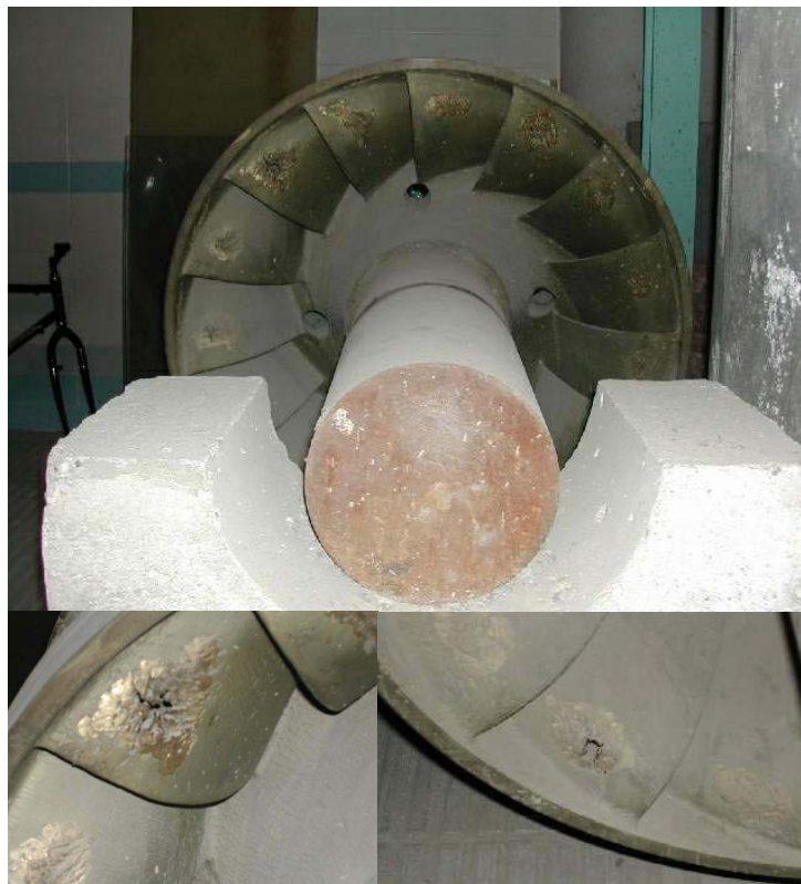
Figura 1.6 Efecte de la cavitació en el rodent d'una bomba axial. A dalt, vista general del rodent: s'hi pot apreciar com tots els àleps, que tenen un gruix d'uns 5 mm, es troben "picats" per efecte de la cavitació. A baix, detalls dels forats que s'han fet en alguns dels àleps.
