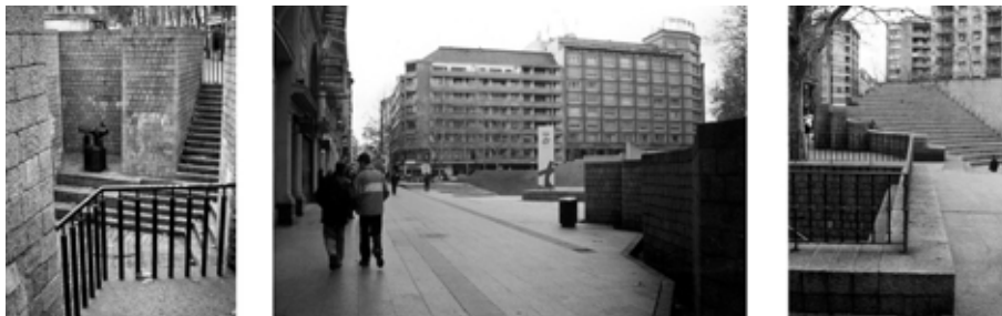
Fotografías de las modificaciones que ha sufrido la plaza desde su inauguración: un nuevo balcón para asomarse al foso al que no se puede acceder, la altura del foso se ha elevado un metro más y barandales rodean el acceso a las boleras subterráneas
