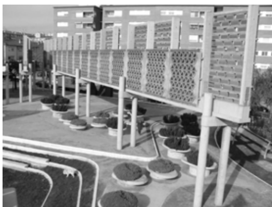
Foto 19. Muros de cerámica 'sin terminar'
