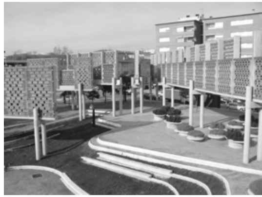
Foto 6. Muros de cerámica
