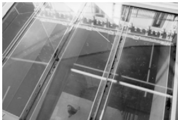
Vista desde el interior al triple espacio de entrada
