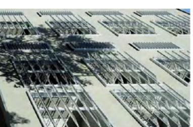
tècnica constructiva a base de planxa metàl·lica soldada, plegada i rigiditzada. Esquelet.
