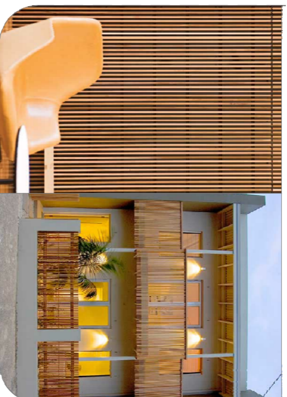
FACANA VENTILADA PROEX El sistema de Facana que s'ha escollit és de motxins i travessers de fusta que s'actuen a l'estructura de formigó reforçat amb un sistema de rastrellat ventilat de panells proex.
