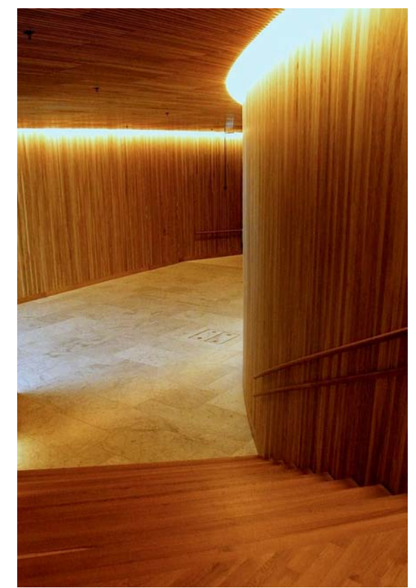
Referencia: Opera de Oslo, Snohetta Vestíbulo con acabado en roble en lamas verticales e iluminación rasante
