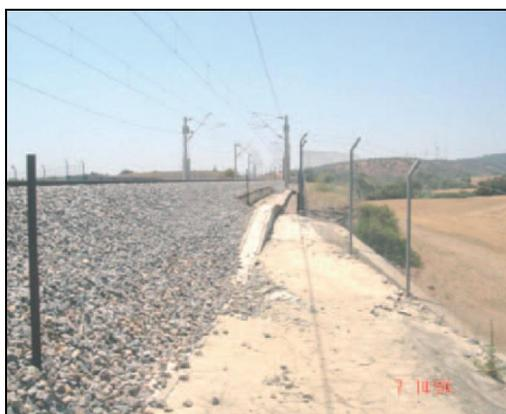
Figura 4.7. Aumento del espesor de balasto debido al descenso del terraplén.
