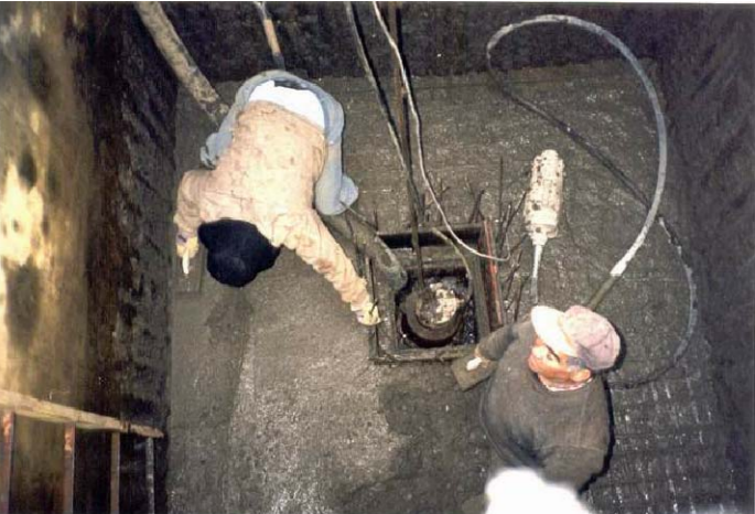
4. Col·locació de pous de bombeig i drenatge del terreny fins que s'assequi la superfície de treball (aquests no aturaran de treballar fins el moment en què acabi l'execució de l'estructura)
