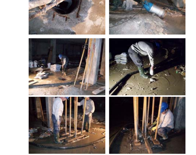
8. Retirada dels pous de bombeig. Segellat del forat.
