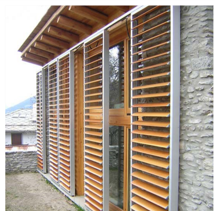
Exemple d'obertura automatitzada dels porticons.
