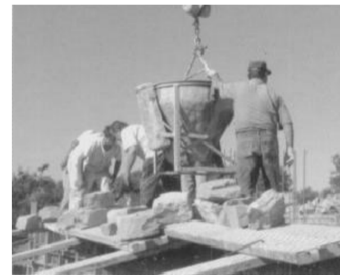
Procés d'abocament i vibrat dels murs de pedra-formigó
