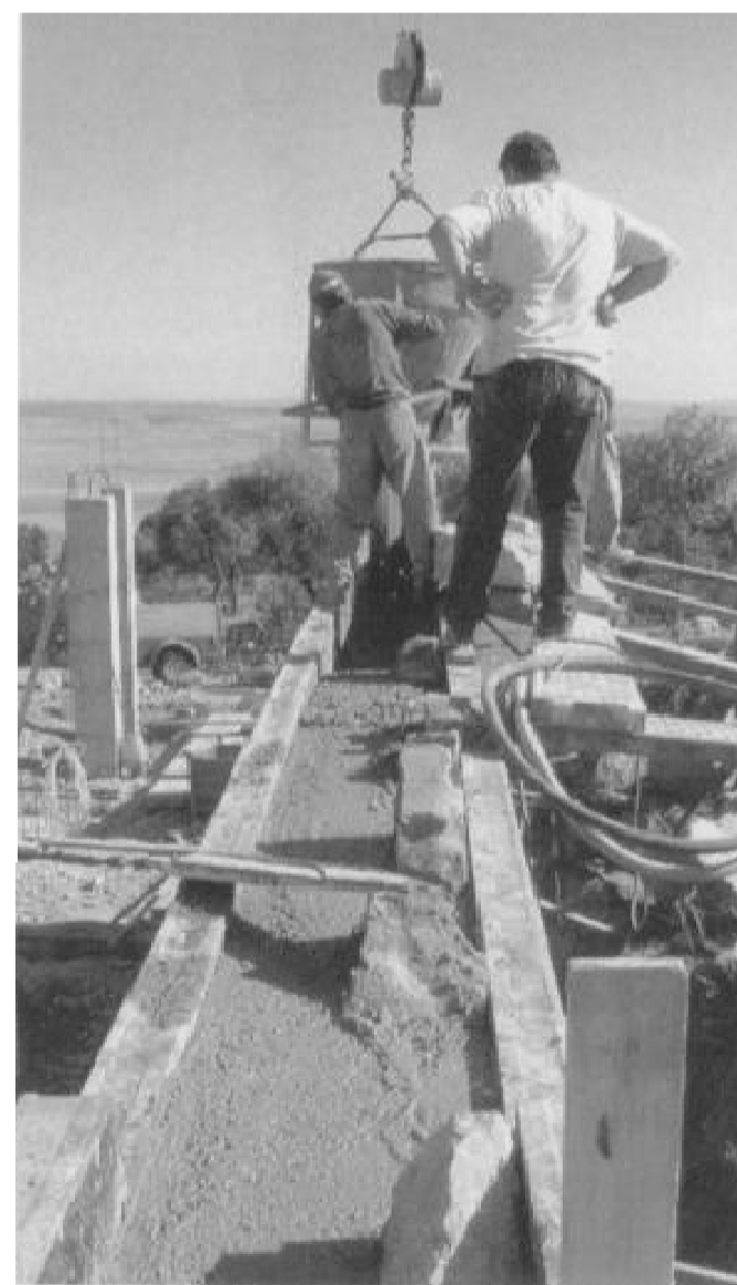
Procés d'abocament i vibrat dels murs de pedra-formigó
