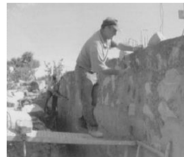
Procés final de neteja de les pedres i picat del formigó per aconseguir la textura desitjada.
