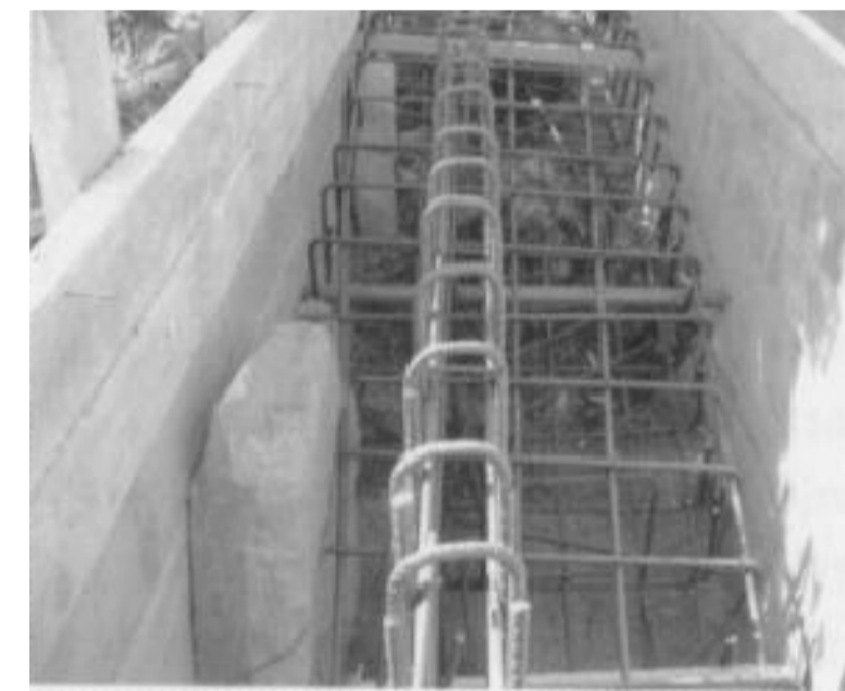
Implantació de la segona cara de l'encofrat i les armadures intermitges.
