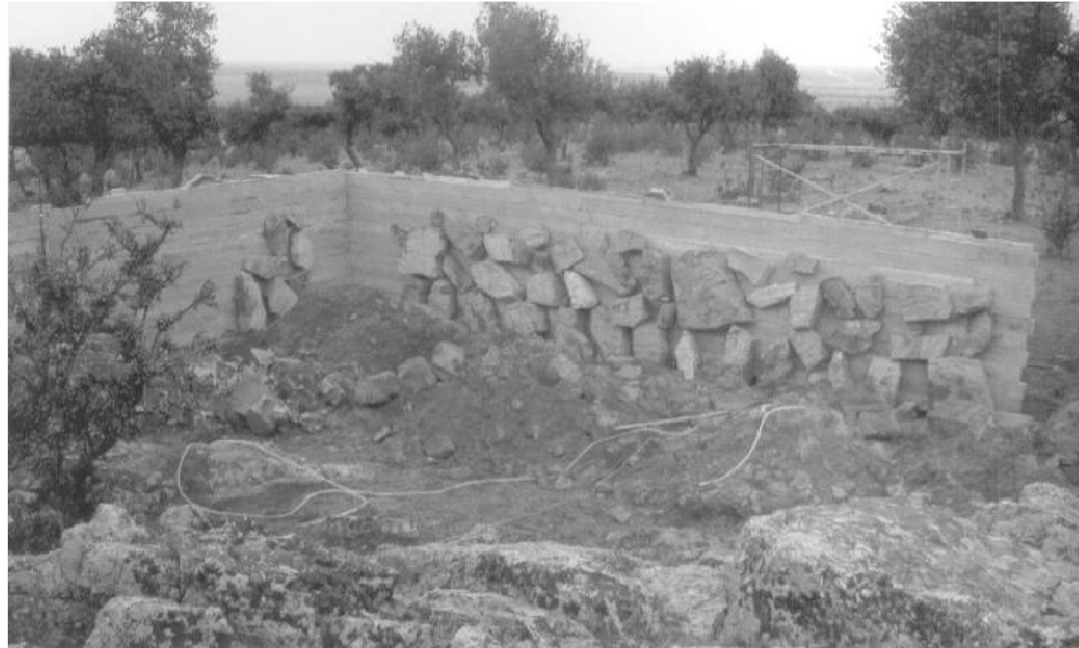
Col·locació de les pedres seleccionades damunt de l'encofrat.
