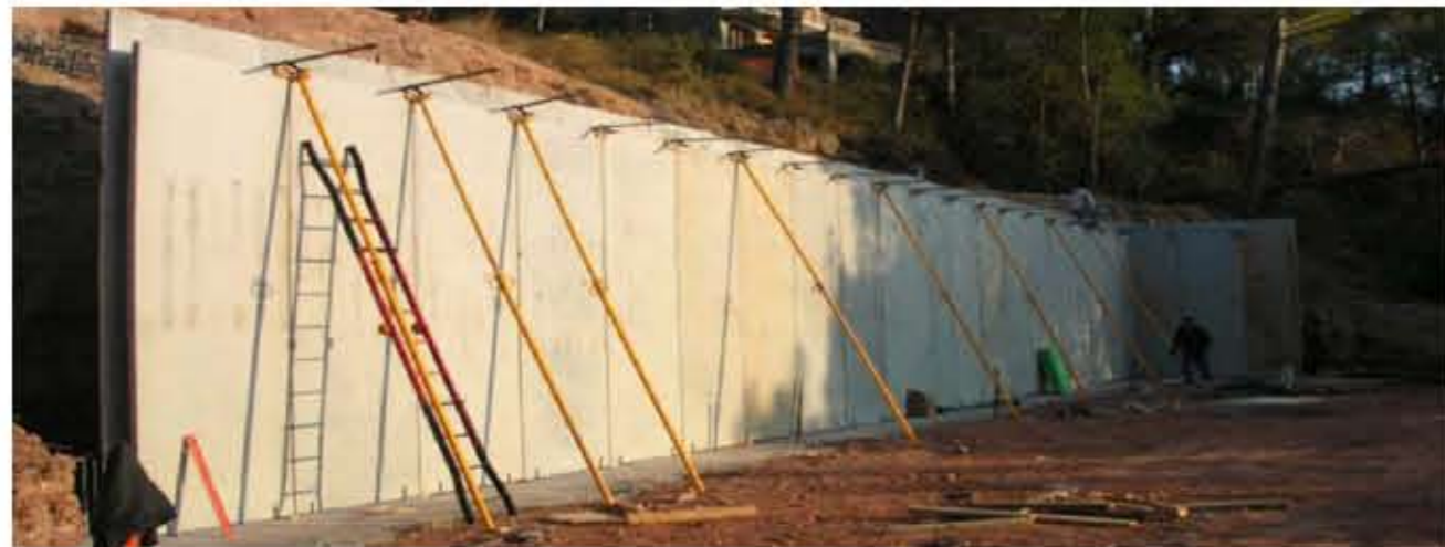
Fotografia de mur de contenció en obra
