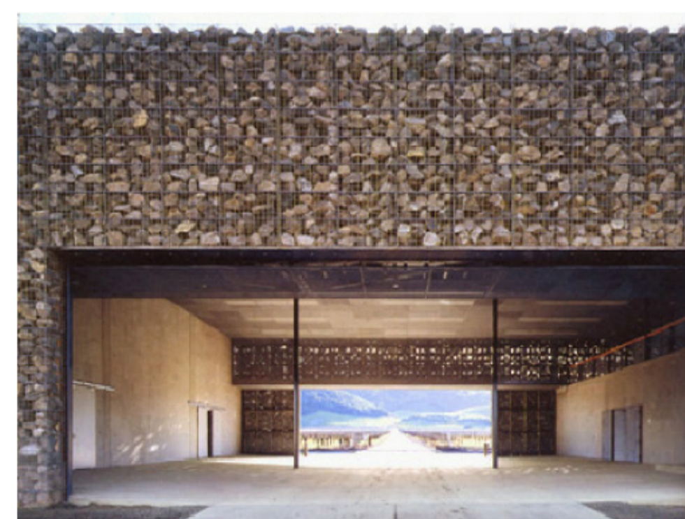
BODEGAS DOMINUS Situació: Yountville (California) Arq: Jacques Herzog i Pierre de Meuron Any Construcció: 1995-96-98 Sup. Const: 3240m2
