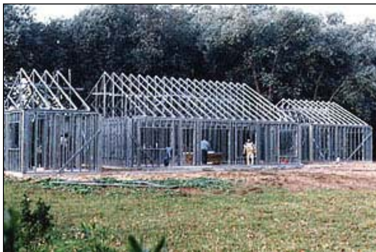
Figura 1.1. Estructura metàl·lica de l'edifici [1]
