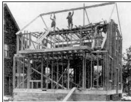
Figura 1.3. Construcció d'un habitatge en Balloon Framing l'any 1935 [2]
