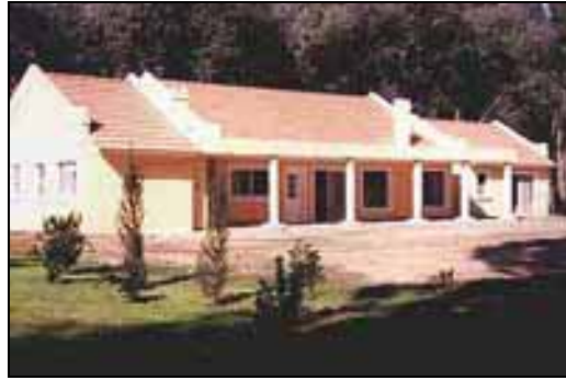
Figura 1.2. Aspecte de l'edifici un cop acabat [1]
