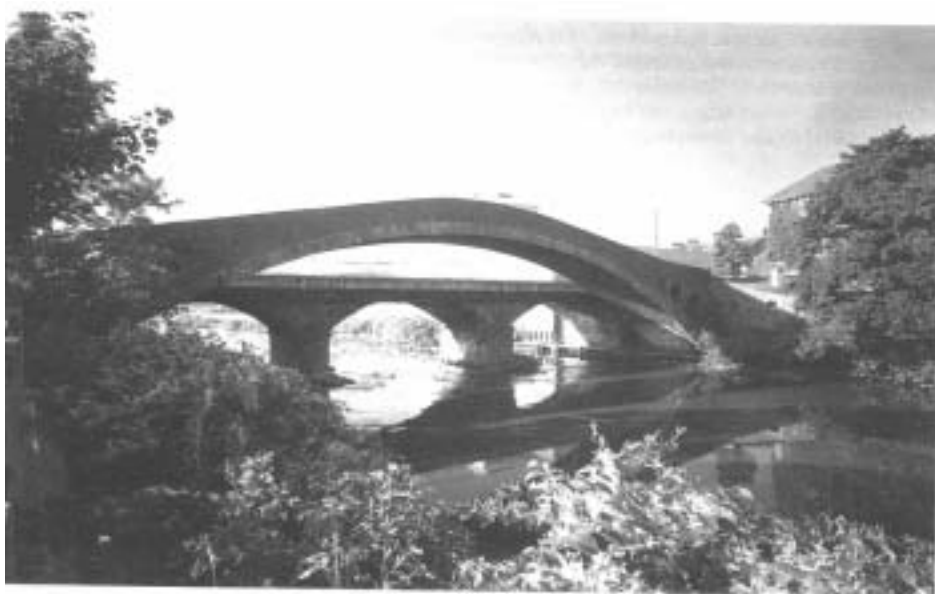
Figura 2-6. Puente de William Edward en Pontypridd. Se pueden apreciar los aligeramientos transversales en estribos en la parte superior derecha de la imagen. Fotografía tomada de [10].
