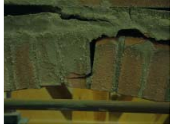
Figura 2-38. Rótulas plásticas en \frac{3}{4} de luz (izquierda) y en centro luz (derecha). Vistas lado montaña. Imágenes tomadas de [3].
