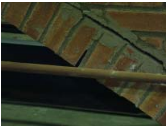
Figura 2-38. Rótulas plásticas en \frac{3}{4} de luz (izquierda) y en centro luz (derecha). Vistas lado montaña. Imágenes tomadas de [3].
