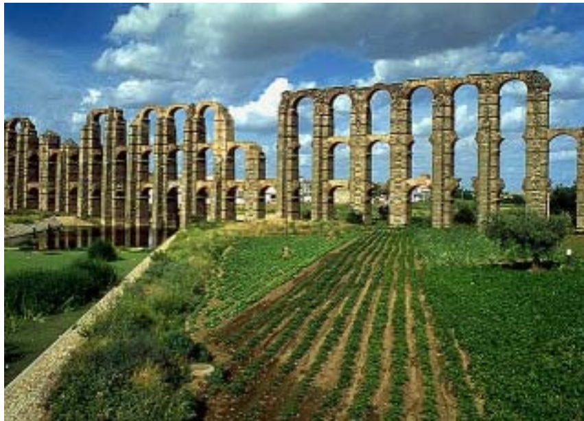
Figura 2-11. Acueducto de los Milagros, Mérida. Dado la gran altura de las pilas se disponen arcos de arriostramiento longitudinal
