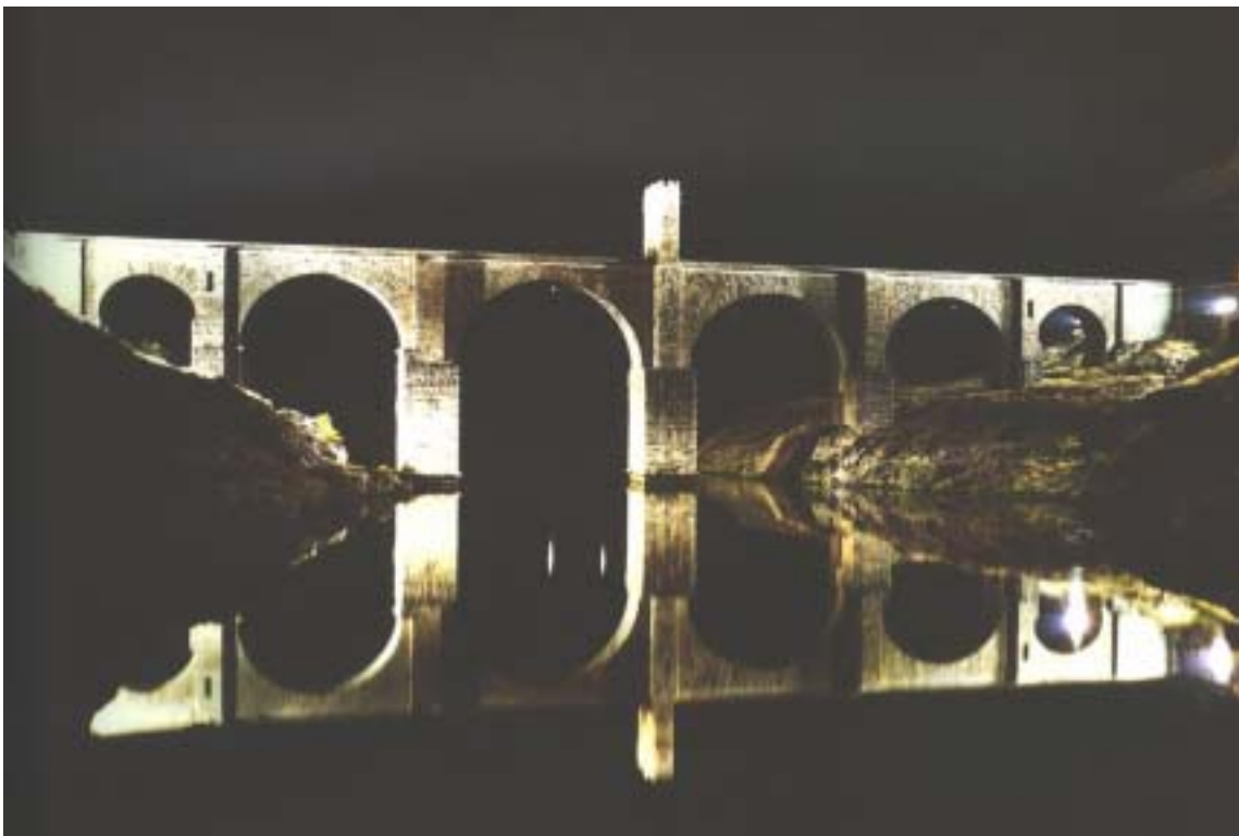
Figura 1-2.- Puente de Alcántara.
