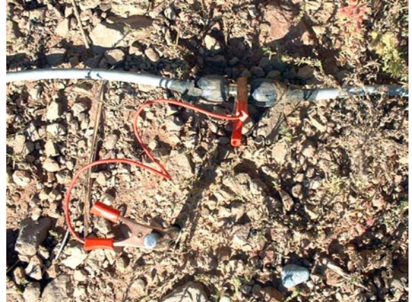
Fig. 9 Detalle de la conexión entre el electrodo y el cable multiconductor.
