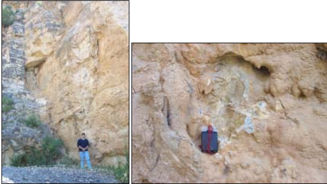
Foto 33 y 34: En estas dos fotografías se puede apreciar el enorme plano totalmente recubierto de material cristalizado. La foto de la derecha muestra un detalle de una del plano. Se ve de manera clara la presencia de circulación de agua.
