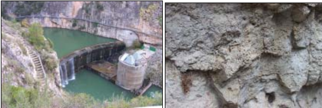
Foto 39 y 40: En la fotografía de la izquierda vemos las escaleras por donde discurre el camino de esta estación. Los márgenes del camino son depósitos de derrubios donde no encontramos ninguna fractura de interés. La fotografía de la derecha nos muestra una zona de roca muy masiva y carstificada donde se intuye una la clara circulación del agua.
