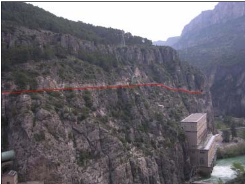
Foto 38: Vista de la cuarta estación. El camino donde hemos tomado los datos está marcado en rojo hasta la entrada de un pequeño túnel, después sigue por detrás de la montaña hasta el pie de la central.
