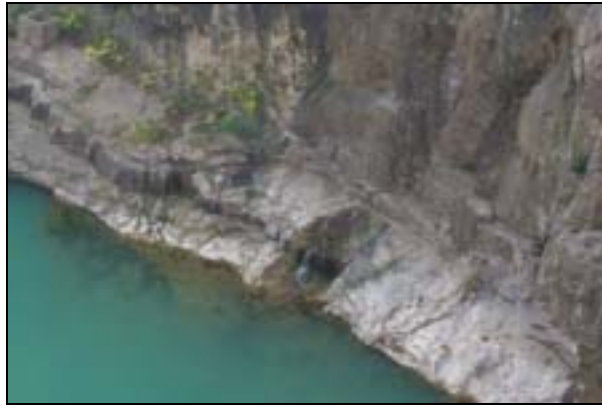
Foto 18: En esta fotografía se observa una fuente existente en la margen derecha del Noguera, justo aguas abajo de la presa.
