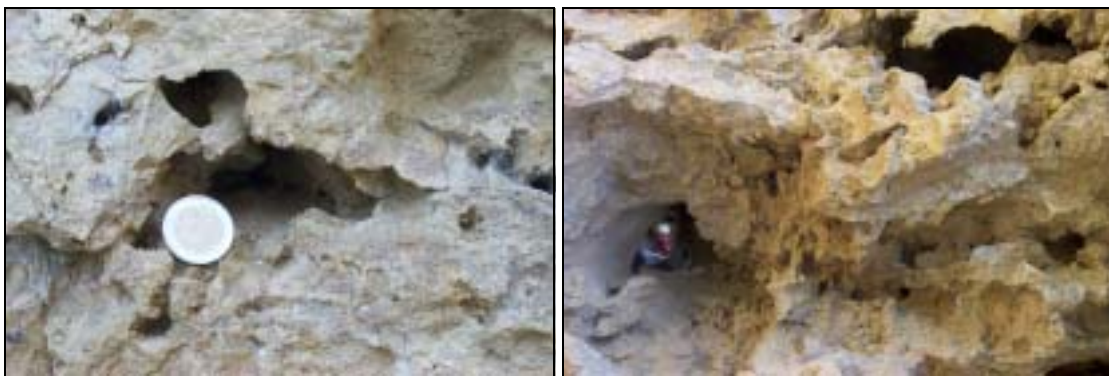
Foto 2: Estas dos fotografías muestran ejemplos de carsts de diferentes tamaños existentes cerca del estribo derecho de la presa de Camarasa. Son un claro ejemplo de la circulación del agua existente en esa zona.
