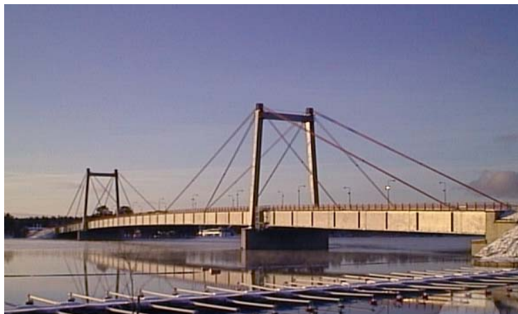
Foto 3: Pont de Strömsund, considerat el primer atirantament tal com es coneix actualment. (Font: www.structurae.de ).
