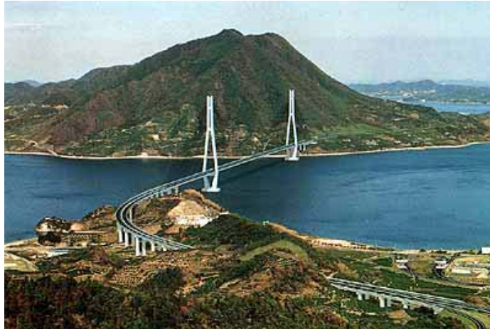
Foto 5: Pont de Tataru al Japó de 890 metres de llum. (Font: www.structurae.de ).
