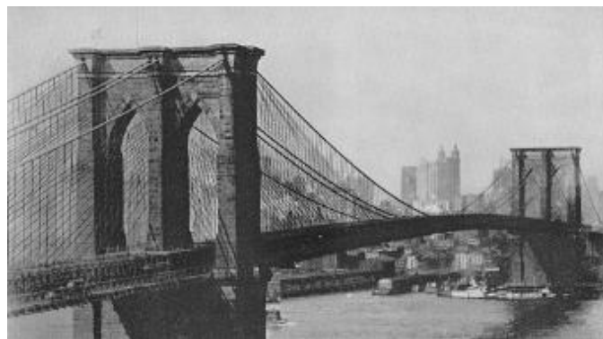
Foto 2: Pont original de Brooklyn (1883). (Font: www.structurae.de ).
