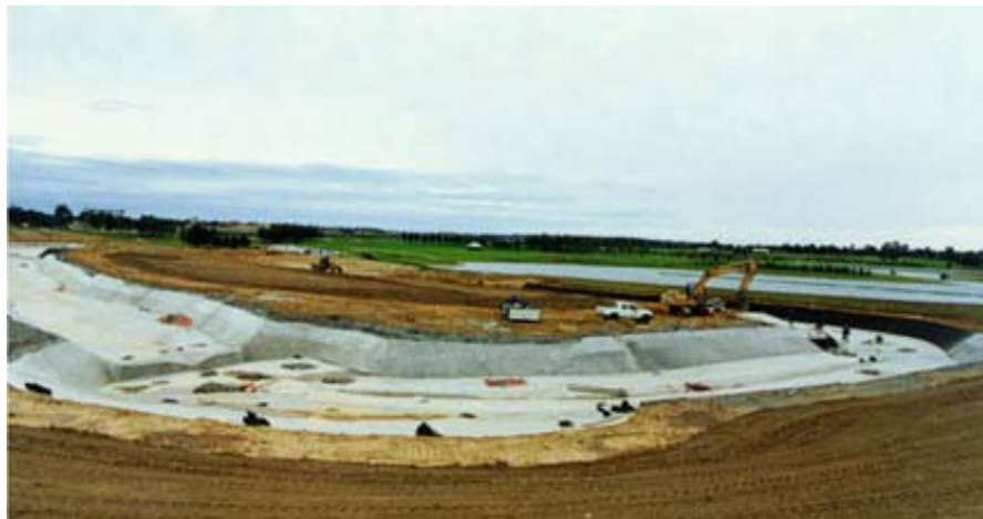
Figura 2.14. Canal Olímpic a Sydney, revestit amb formigó projectat reforçat amb fibres sintètiques.
