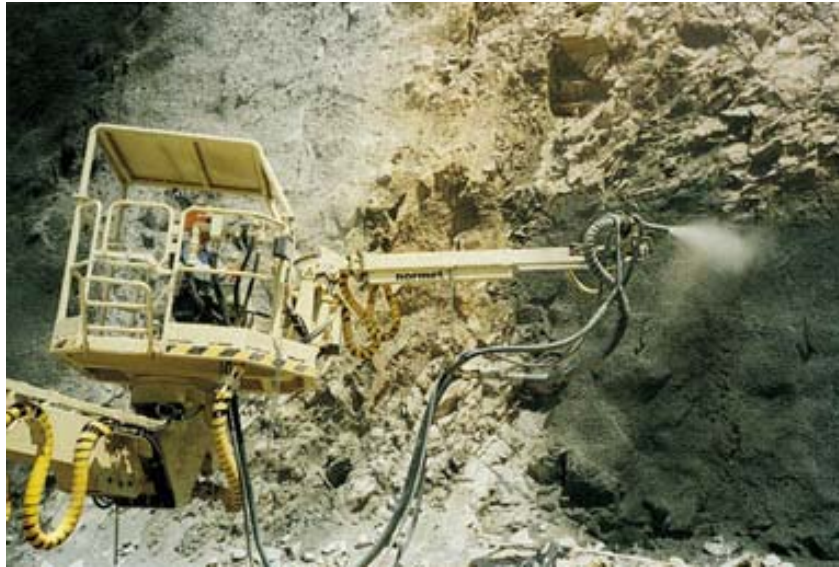
Figura 2.12-a. Estabilització d'un talús mitjançant formigó projectat reforçat amb fibres metàl·liques.
