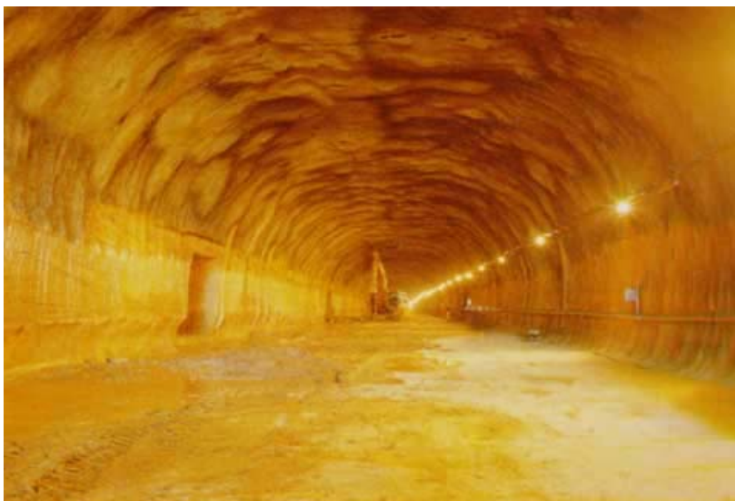
Figura 2.15. Revestiment definitiu d'un túnel a Ontario, Canadà.
