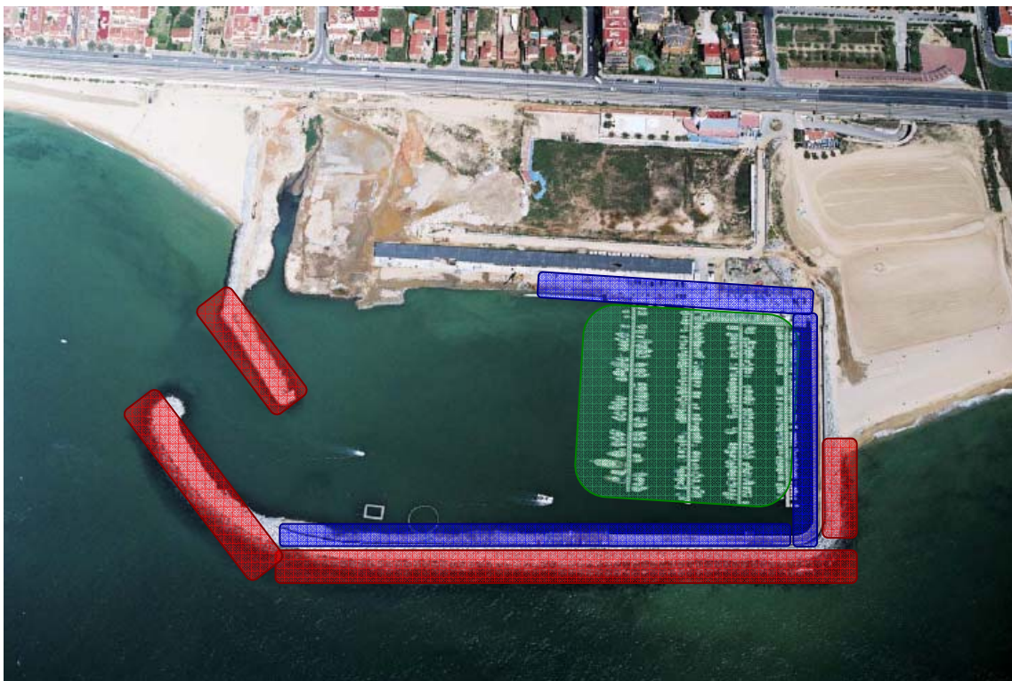
Fig. 5: Planta del port de Premià de Mar en construcció al 2005 indicant les parts bàsiques d'aquest. En vermell està marcat el dic d'escullera i contradic; en blau els molls de formigó; i en verd els pantelans flotants. [Modificada de Ruiz, J. i Romero, D. (2007)]
