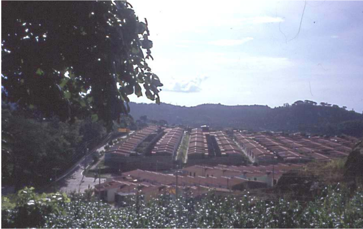
Fotografía 39. Residencial Brisas de Zaragoza. Fuente propia (ESF-CORDES) (Julio-Sep 2002)
