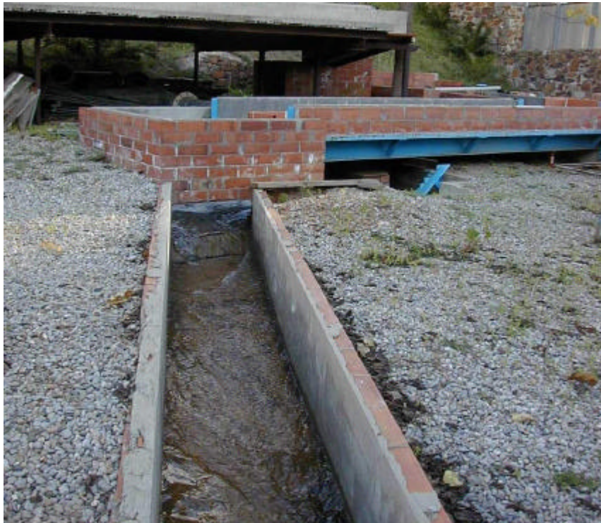
Figura 3.7: Fotografía de la arqueta de salida y canal de desagüe en la dirección y
