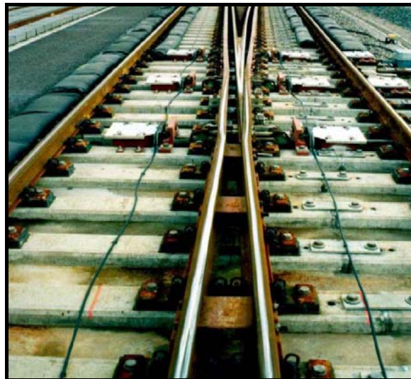
Figura 2.11. Corazón de punta móvil. Fuente: JEZ. Sistemas Ferroviarios.
