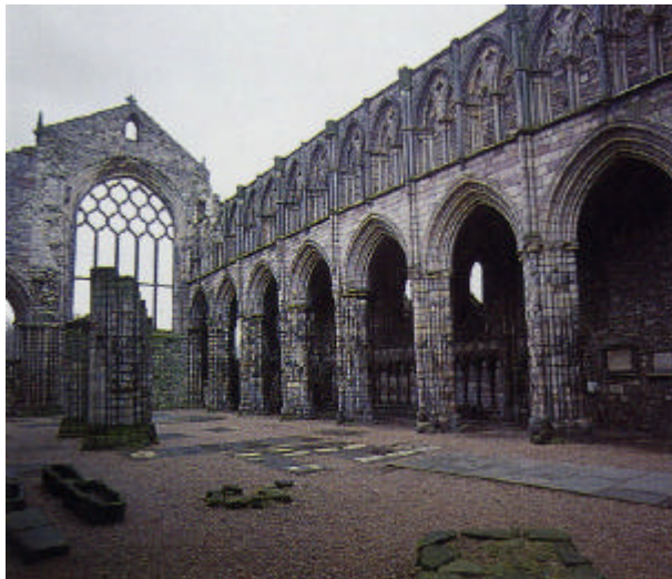
Fig 3.6: Hoy la Abadía permanece en ruinas, eclipsada por el Palacio de Holyrood.
