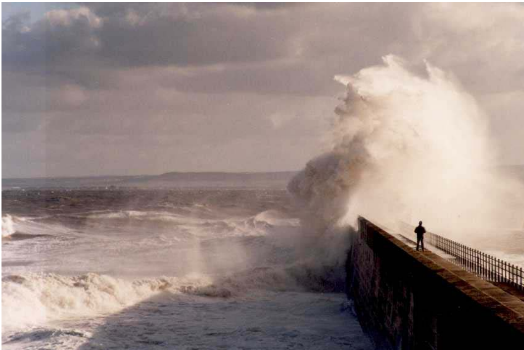
Imagen 1.1. Rebase del oleaje sobre una estructura marítima vertical.
