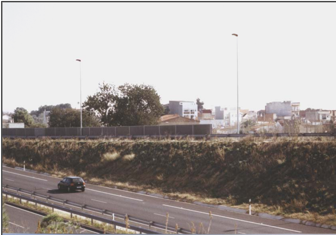
Foto 22: La urbanització La Plana està massa aprop del traçat de la Variant Sud inaugurada l'any passat, calia protegir-la acústicament mitjançant pantalles de formigó. Autor: Jordi Rius i Perpinyà
