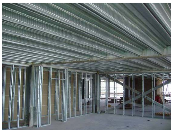
Figura 3.3. Construcción de forjados colaborantes utilizando chapas de gran canto.
