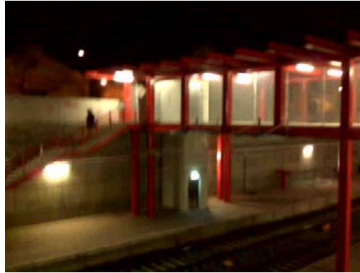
Figura 2.9. Paso superior en la estación de RENFE de Vilafranca del Penedés.
