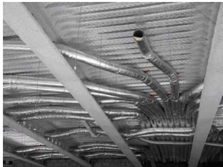
Figura 2.7. Colocación de servicios.
