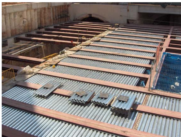
Figura 2.12. Nuevo forjado vestibulo estación Sagrera, debajo de la Meridiana.
