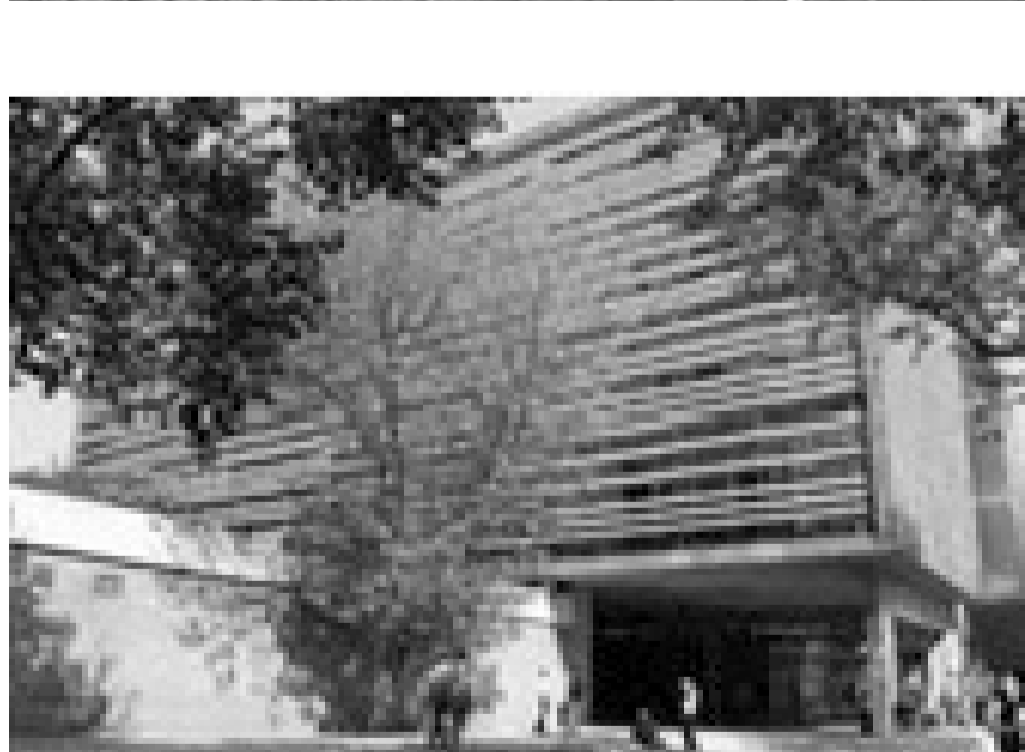
FAÇANA VIDRE AMB PROTECCIONS SOLARS, UNIVERSITAT D'ARQUITECTURA DE SEVILLA
