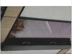
Universitat d'Oxford, Norman Foster façana realitzada amb sistema CWB8 de Reynolds, a partir de panells de vidre fix, panells sandwich, finestres projectants automatitzades i finestres amb obertura paral·lela.
