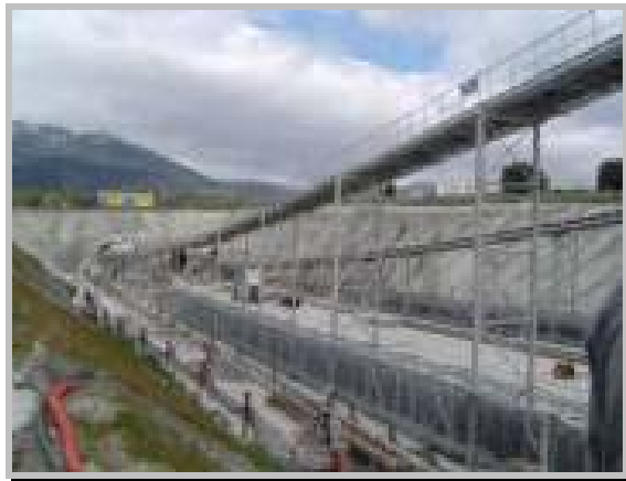
Fotografía 5.- Cinta transportadora de escombros.
