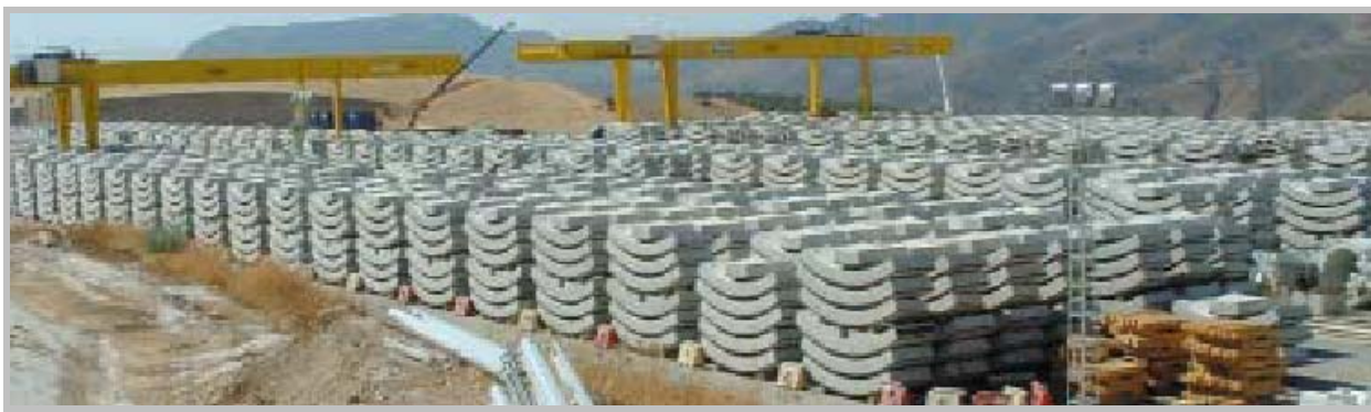
Fotografía 4.- Vista de la zona de acopio de dovelas
