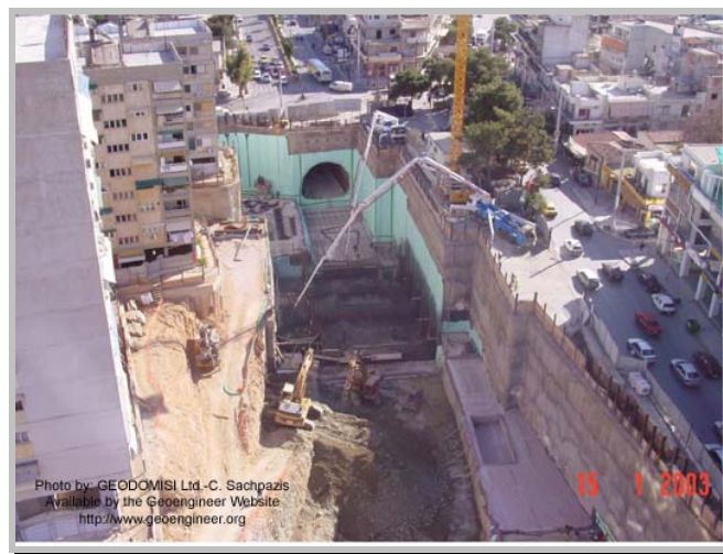
Fotografía 12.- Pozo de ataque
