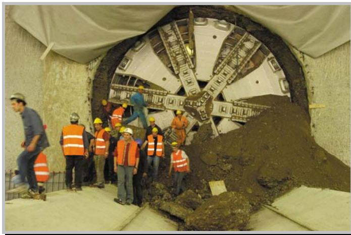
Fotografía 6.- Cabezal de excavación
