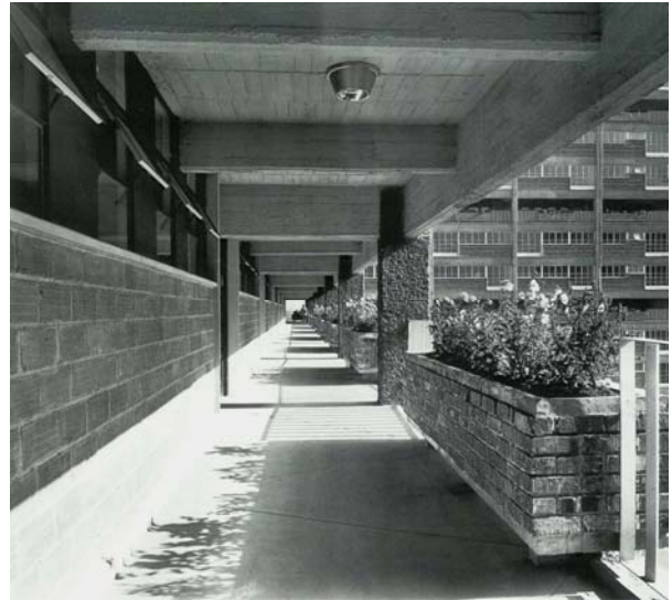
Img.22. Vista parcial del los corredores del CUPA. Foto: Guillermo Zamora. Fuente: Pani, 1952.
