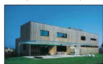
(6) FUSTA SENSE DESBASTAR (REVESTIMENT EXTERIOR)
