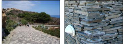
El buen criterio con el que ha sido empleada la pizarra en los zócalos de las construcciones existentes, simplemente apoyada en la roca y aparejada en seco, sin excavación ni mayor cimentación que el propio zócalo, permite su reutilización y transformación, sin aumentar la superficie de suelo ya comprometida.
