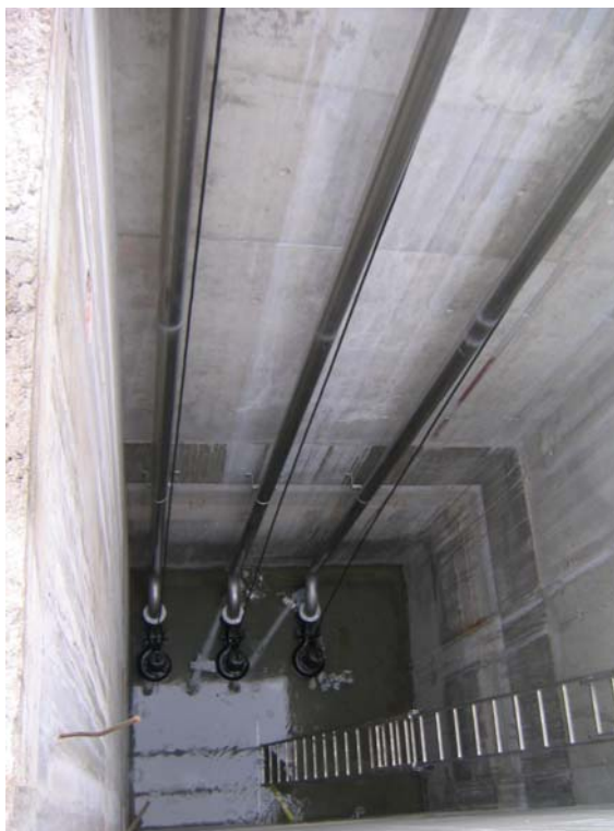
Figura.4.1.3.1 Pozo bombeo inicial.
