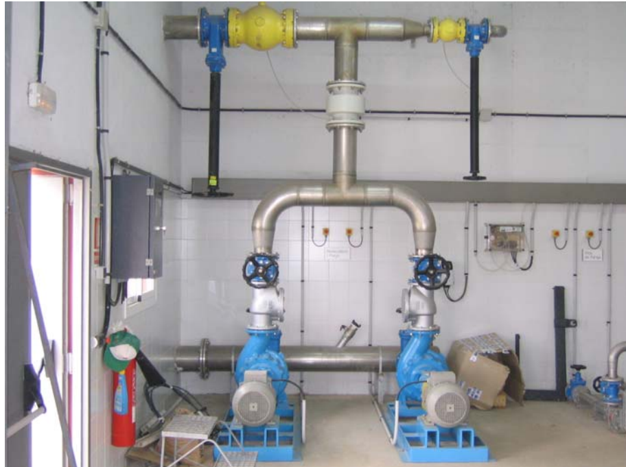
Figura.3.2.2.2.1 Recirculación y purga de fangos.
