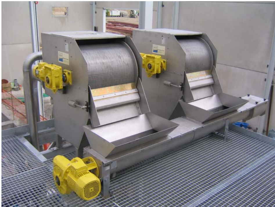
Figura.4.2.4.1 Tamices rotativos.
