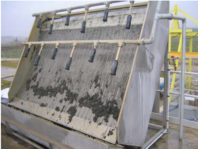
Figura. 3.2.1.1.2.1 Tamiz Hidranet
