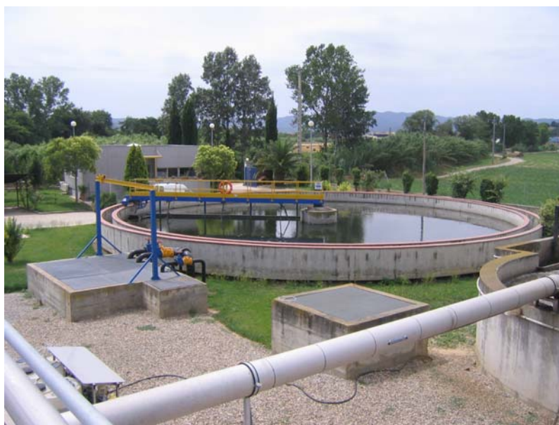
Figura.3.2.1.2.2.1 Decantador secundario
