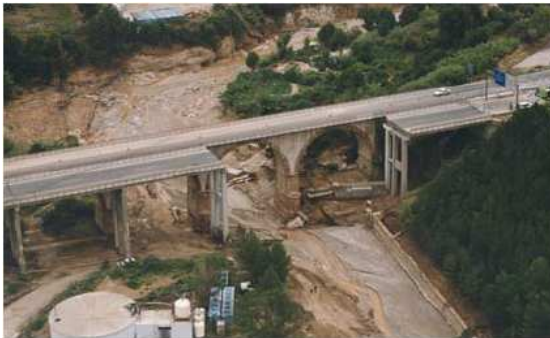
Foto 1. Caída del puente sobre riera Magarola; construcción del puente nuevo. ( www.comsa.com/pdf/INGENIERIA/Fornells_de_la_Selva(M.FOMENTO-DGC).pdf )
