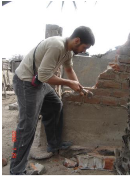
Imagen 5.1. Tareas de construcción del invernadero
