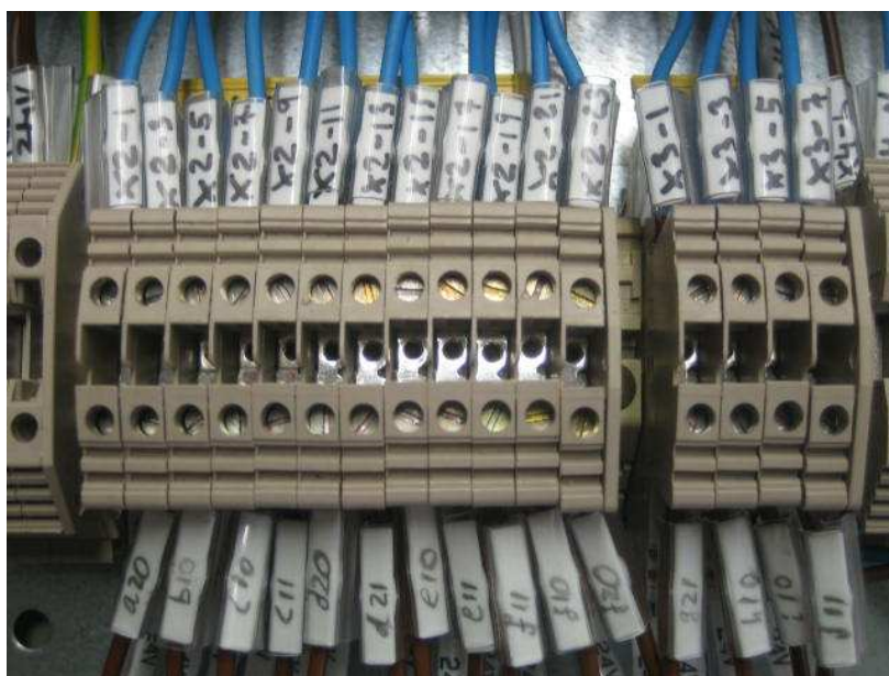
Figura 8.4. Bornero de interconexión
