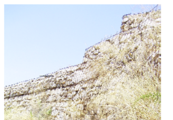
murs de contenció
