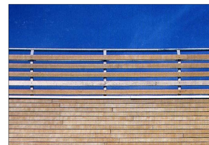
12. FAÇANA. LAMES DE FUSTA D'IROKO
