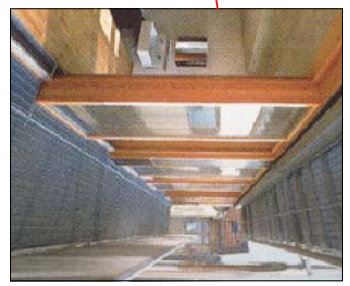
Fabrico de fusta mòbils, en tall verticals La ventilació natural del parking es produeix en dues franges llargues que permeten una bona entrada de renovació d'aire
