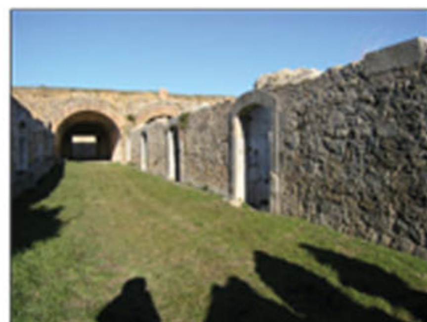
Vista exterior passadís i casamata principal del baluard
