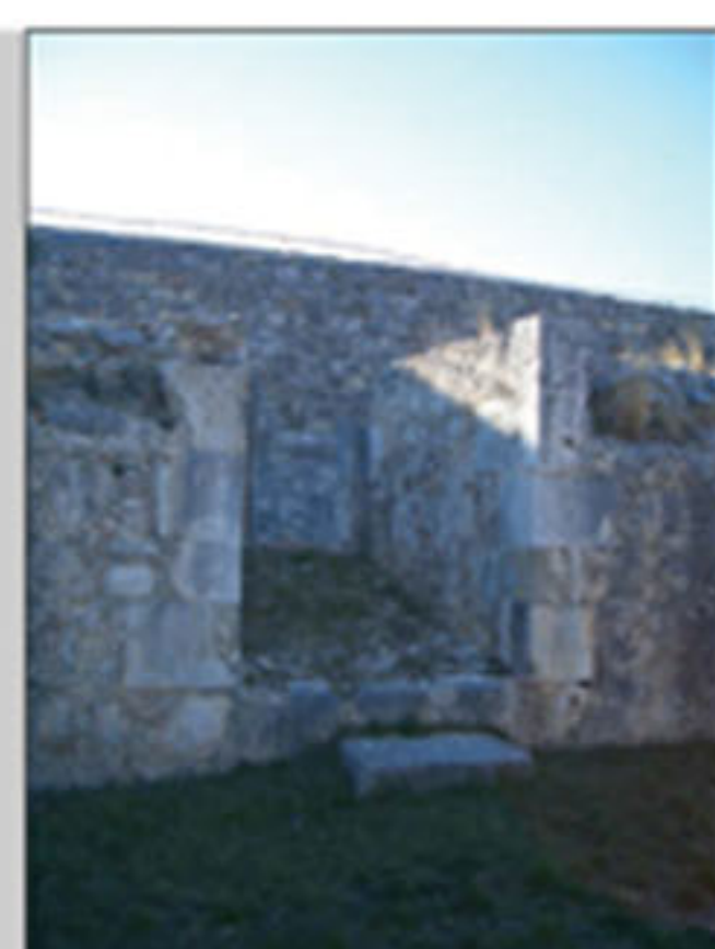
Detall obertures mur
