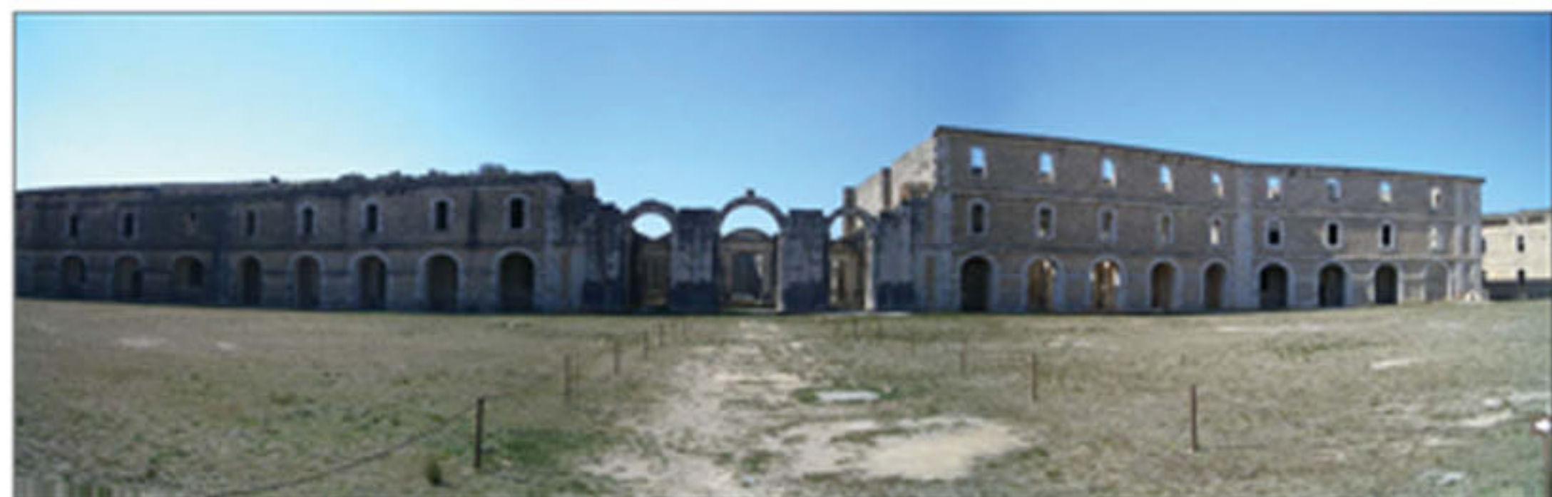
Vista des de plaça d'armes edifici allotjament i església
