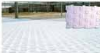
MUNTATGE PAVIMENT RADIANT
