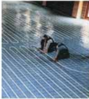
MUNTATGE PAVIMENT RADIANT
