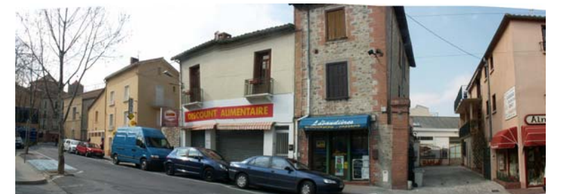
4. VISTA PASSATGE ENTRE EDIFICIS
